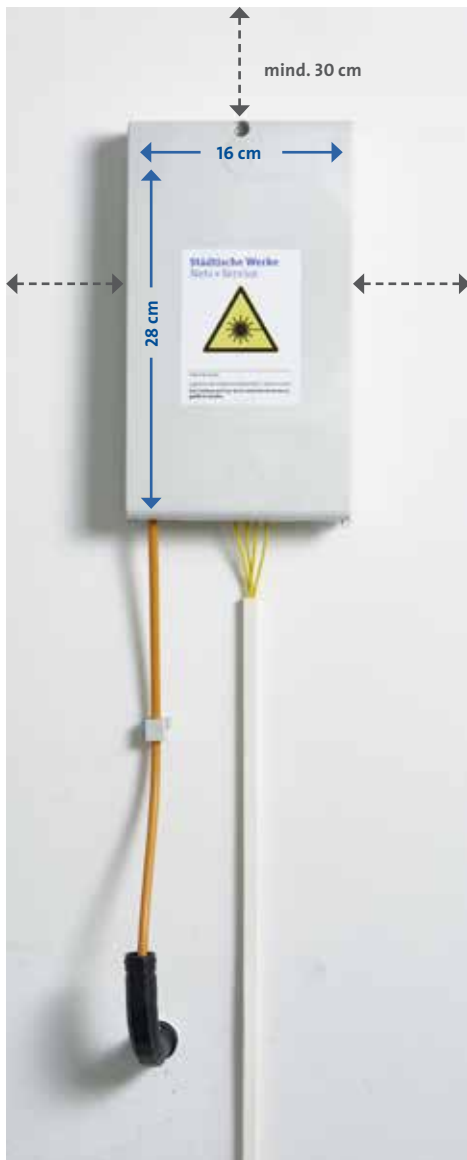
Glasfaser-Hausübergabepunkt (Gf-Hüp) mit Hauseinführung (Mikrorohr 7 mm) und Gebäudeverteilung
